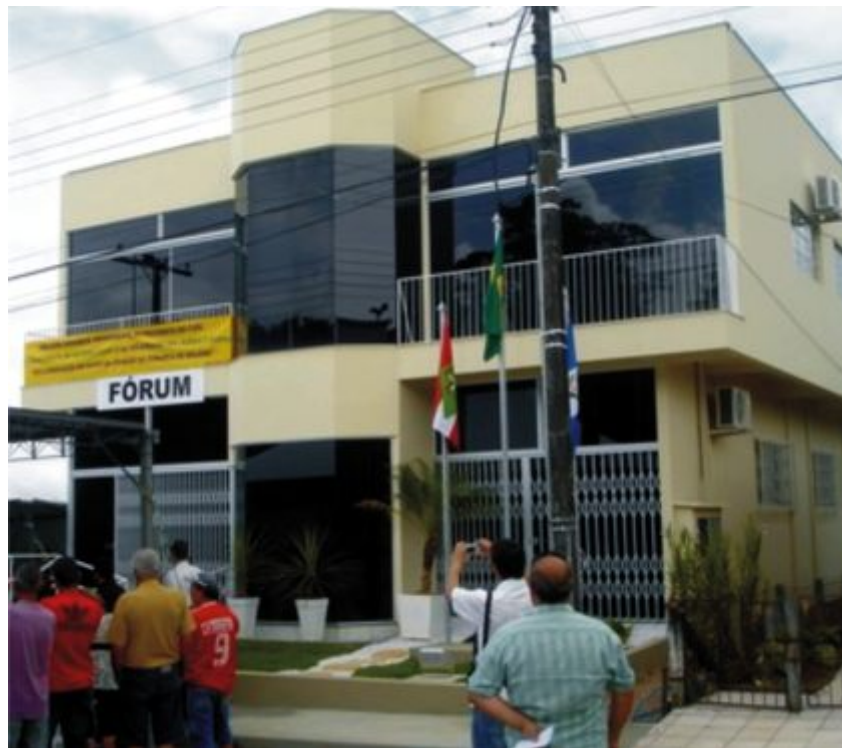
Instalação da Comarca de Meleiro
